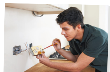
3 lavori di manutenzione / riparazione
