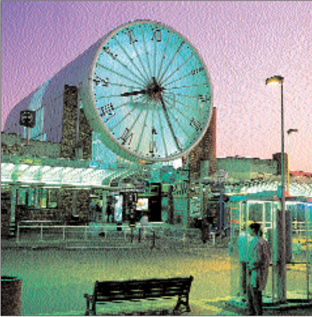
◀ La gare de Cergy-Pontoise (Val d'Oise)
