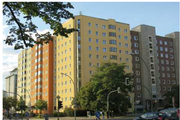
Renovierte Plattenbauten im Osten von Berlin
